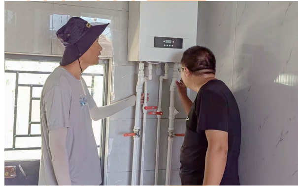
项目建设人员查看农户家中的天然气供暖设施(9月16日报)。本报记者 李阳阳 摄
