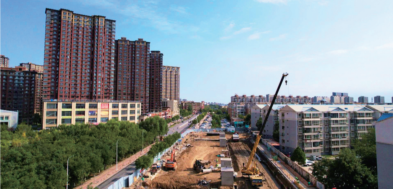
9月19日，兴庆区西北部片区排水防涝设施——雨水调蓄池建设工程(二期)正在加紧施工。本报记者 宋志书 林芸 摄
