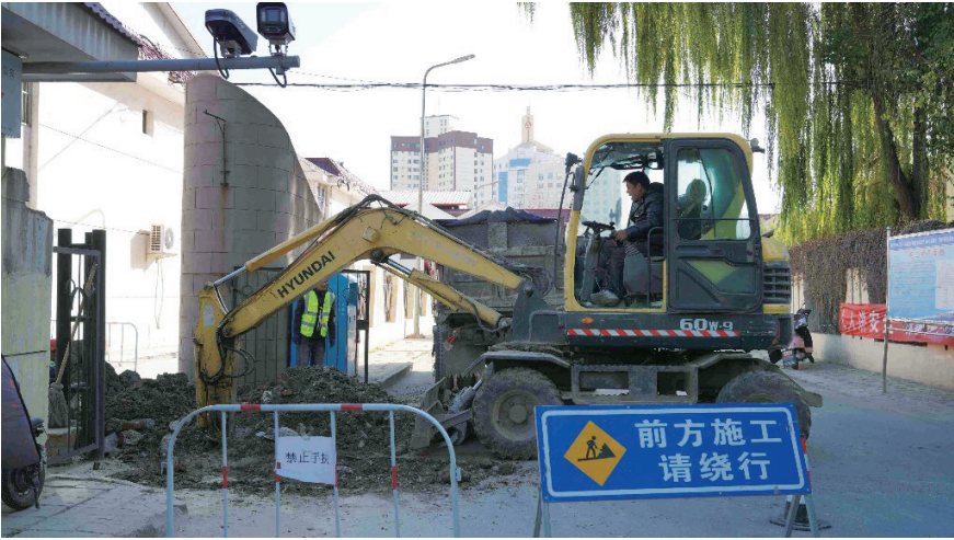
老旧小区改造项目施工现场(11月16日摄)。
