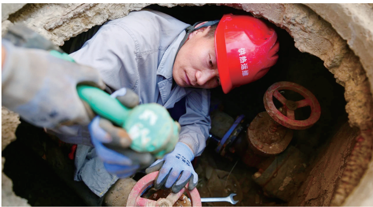
国能宁夏供热有限公司工作人员正在维修供热管网。本报记者 李鲲鹏 摄
