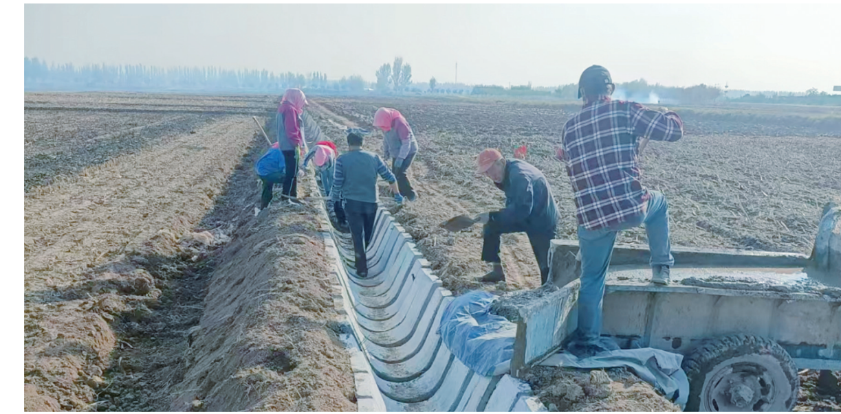
渠道砌护施工现场。本报记者 刘嘉怡 摄
