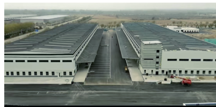
施工现场。受访者供图
