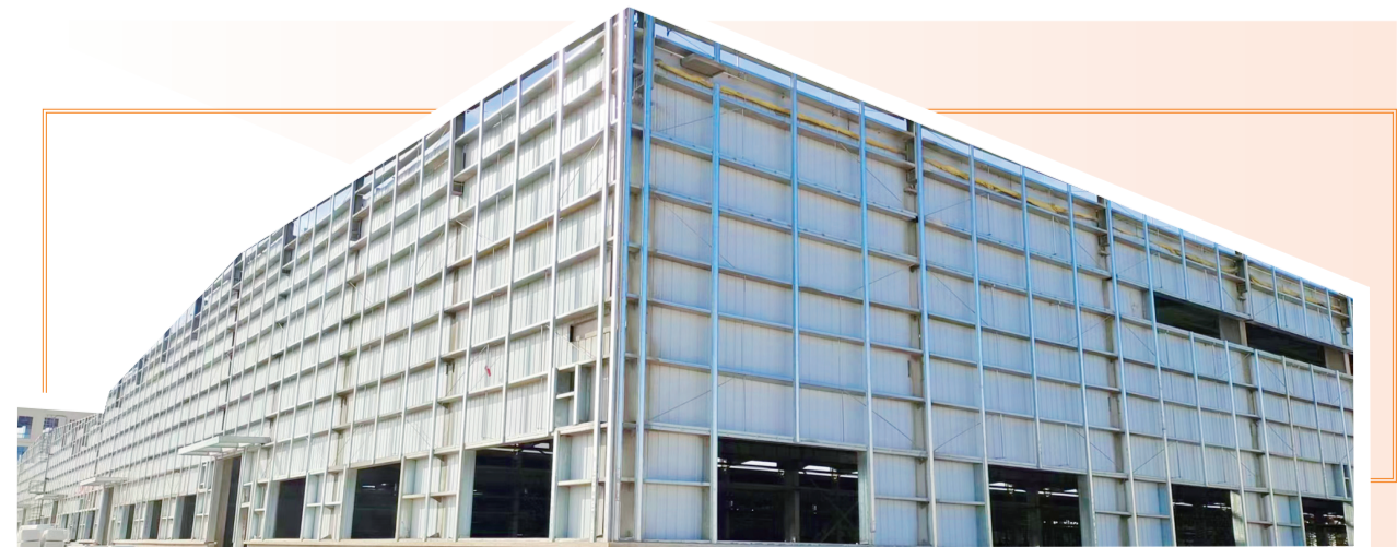
新型铅碳长时储能电池生产基地项目施工现场(12月17日摄)。本报记者 李鲲鹏 摄
