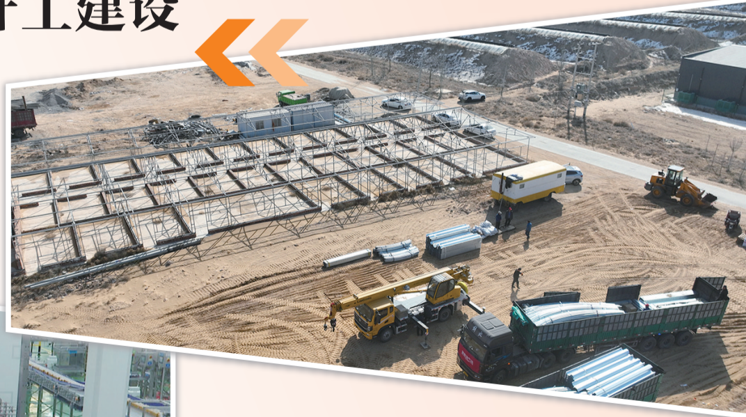
靈武市大型集約化育苗中心項目建設現場(2月18日攝)。本報記者 李鯤鵬 攝
