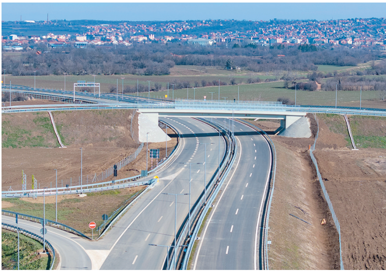
这是2月22日在塞尔维亚拍摄的中企承建的“多瑙走廊”快速路项目路段（无人机照片）。新华社发
