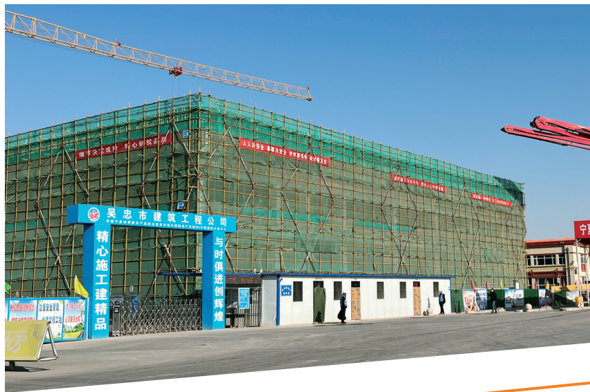
四季鲜市场二期项目建设现场(2月27日摄)。
