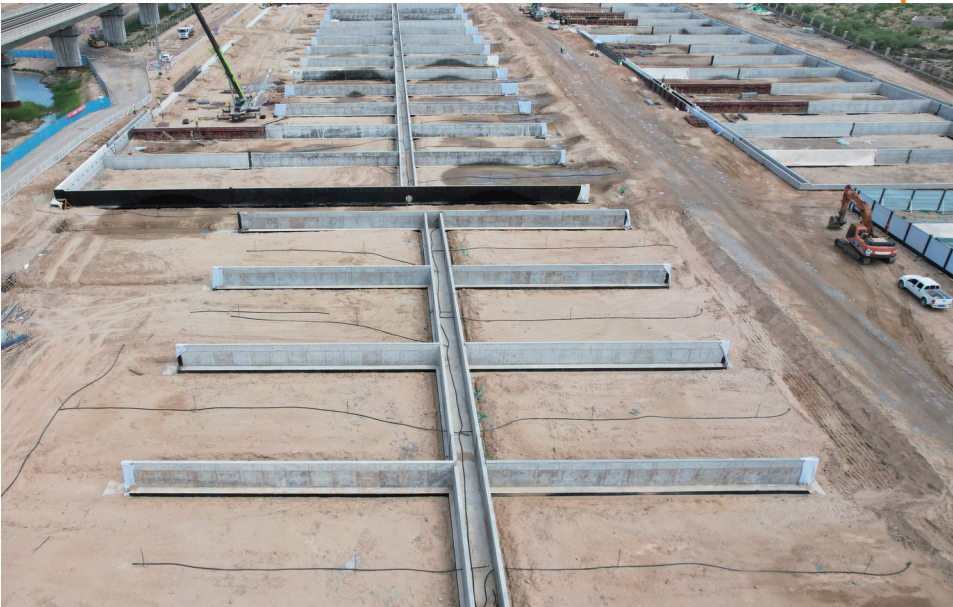
银川市第七污水处理厂再生水工程施工现场。本报记者 李鲲鹏 摄
