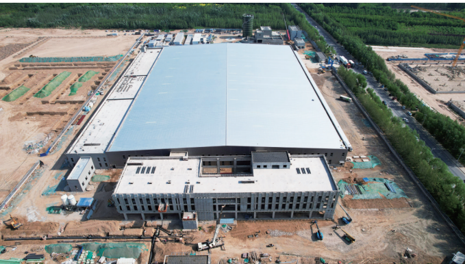
原源(宁夏)新质乳品精加工生产项目车间主体已封顶。本报记者 梁小雨 摄
