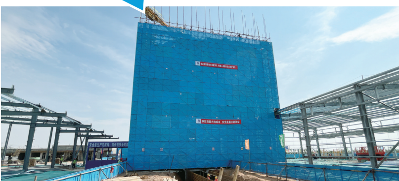
山海饲料项目建设现场。
