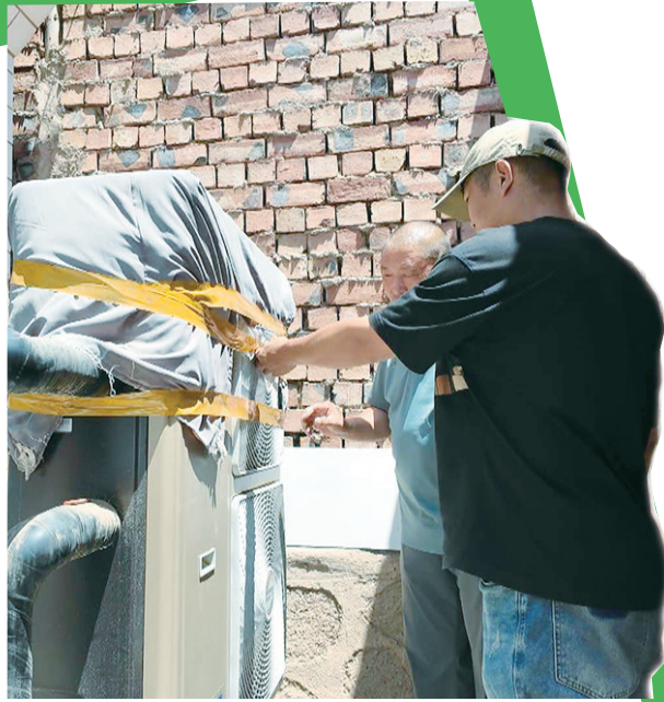
木兰村村民展示新安装的煤改电取暖设备。
