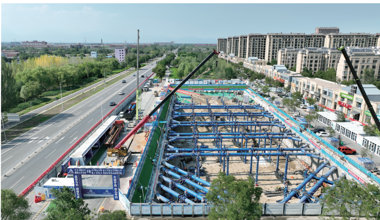
西夏区中部文萃北街调蓄水池建设工程现场(8月1日摄)。
