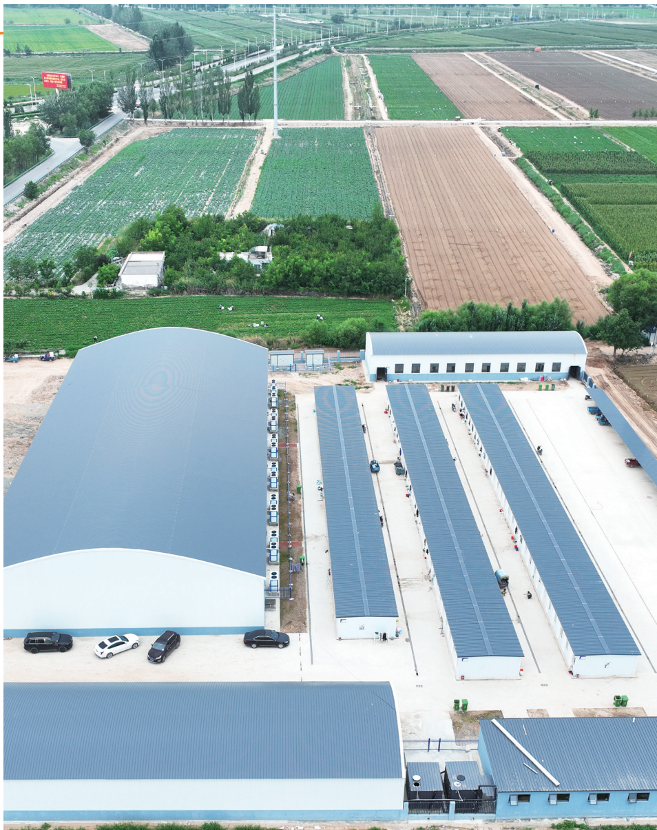
同庄村蔬菜基地二期冷库已投入使用。
