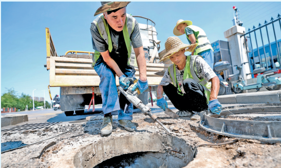
市政部门加紧维修下水管道和排水设施。
