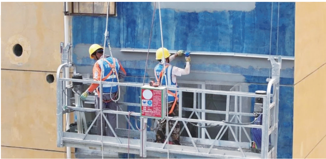
改造中的兴发小区。
