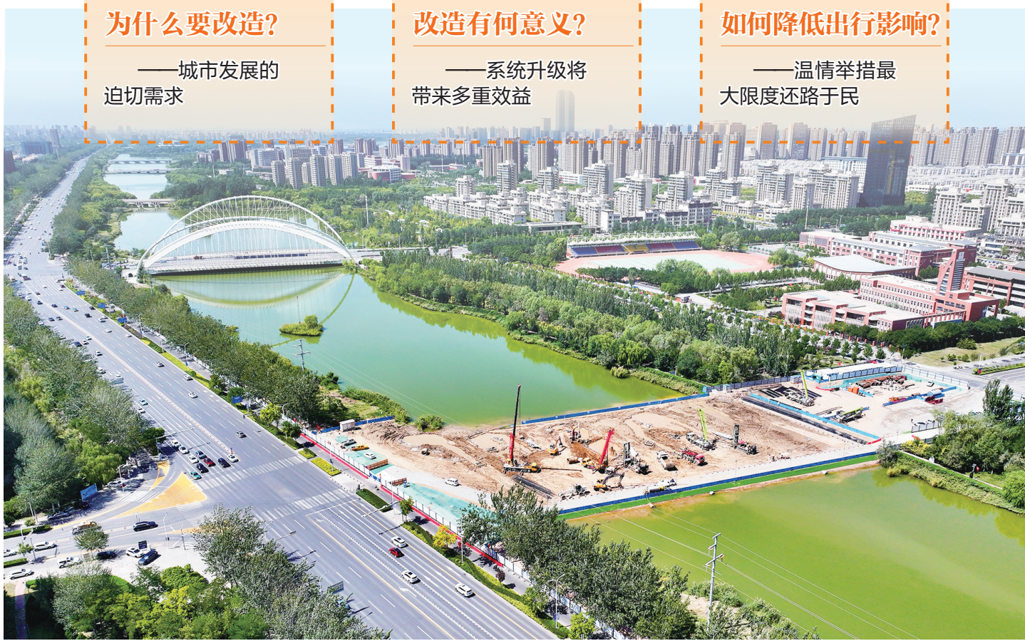
在银川市天平街道路及桥梁工程(上海路—滨河路)项目现场,施工车辆穿梭往来,施工工人正紧锣密鼓地推进工程进度。本报记者 李靖 摄
