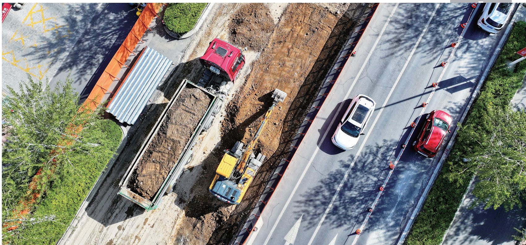
民族街（上海路—贺兰山路）道路改造工程现场。
