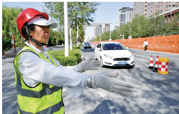
交通疏导员在路边指挥车辆有序经过施工区域。
