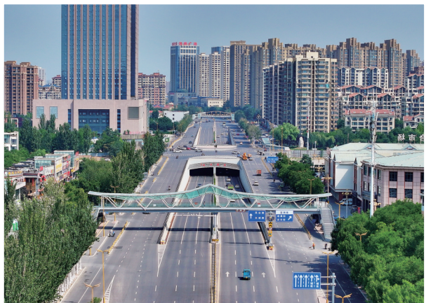
正源街与宝湖中路交叉路口架起凤悦隧道。
