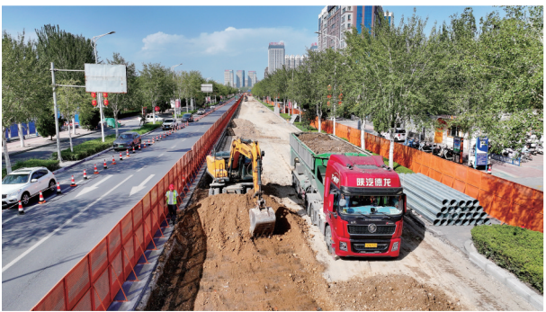
民族街(上海路至贺兰山路)道路改造工程全力推进施工进度。
