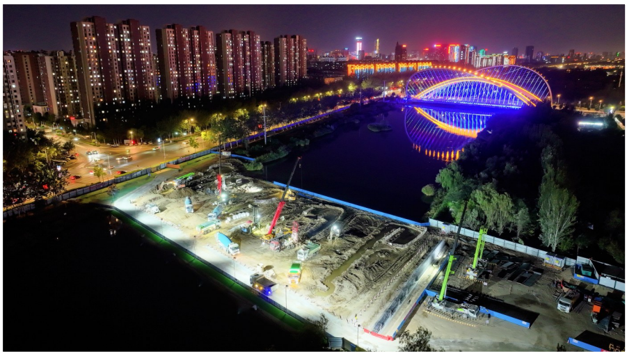
夜间,天平街道路及桥梁工程(上海路—滨河路)施工现场加足马力。
