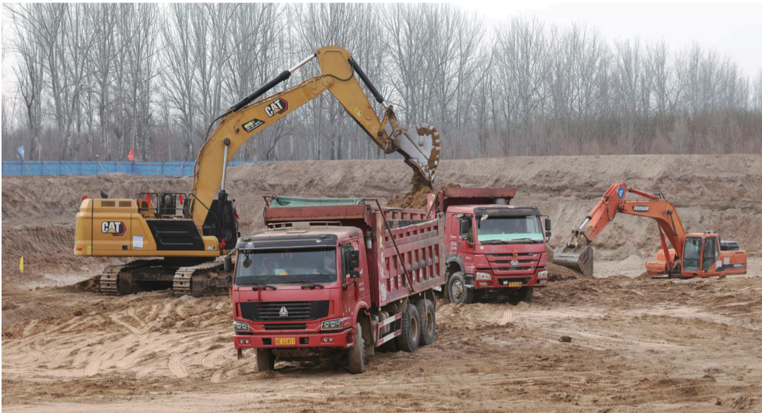
项目施工现场,挖掘机长臂挥舞,运输车辆穿梭不息。
