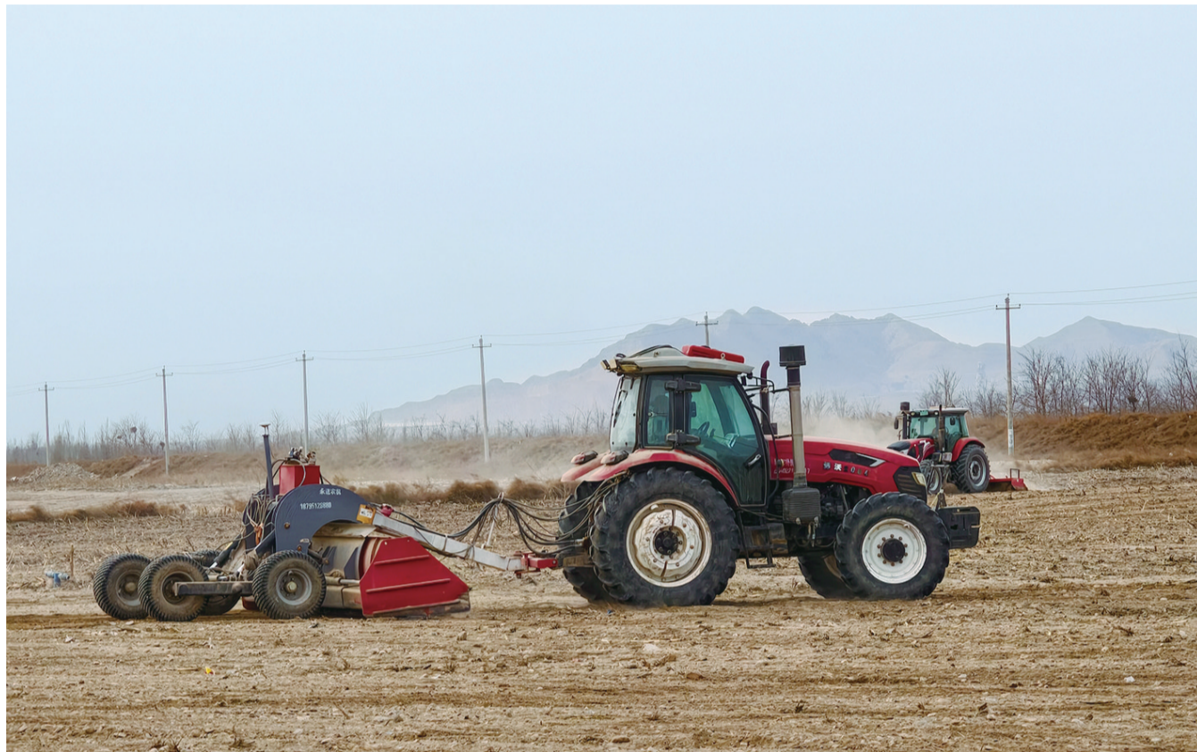
西夏区镇北堡镇矿山生态修复项目现场。本报记者 李姝 摄
