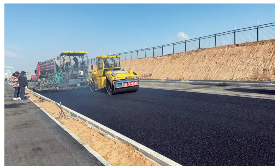
园区道路施工现场。
