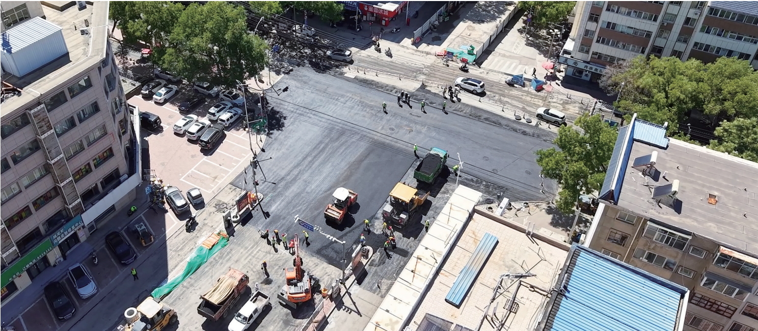
湖滨路(清和街至凤凰街)老旧管网改造工程施工现场。
