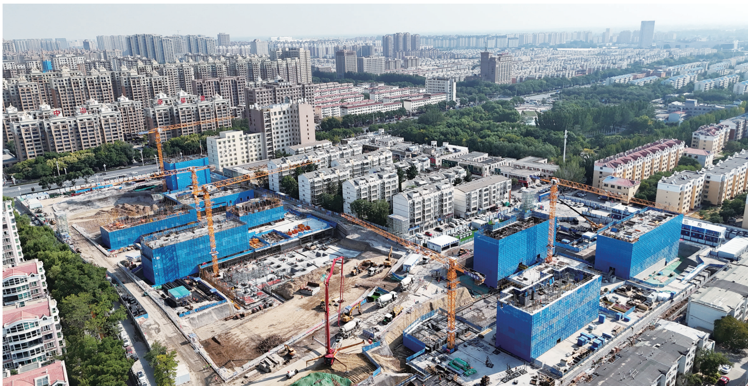
兴庆区中部零散城中村改造项目正在加紧建设(9月16日摄)。
