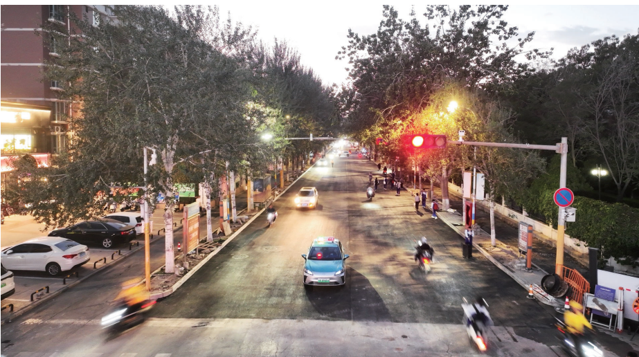
书苑巷(敬德街—民族街)老旧管网治理收官,道路开放通行。本报记者 肖梦琪 摄
