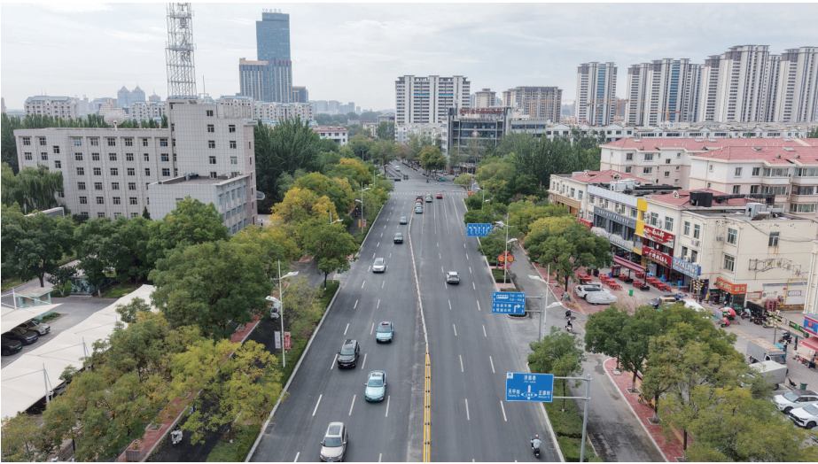
凤凰街(贺兰山路—上海路)改造竣工,路面平整、标线清晰。本报记者 李鲲鹏 摄
