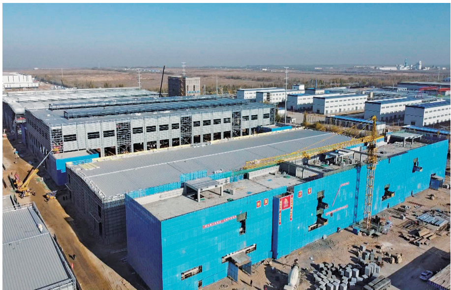
项目正在加紧建设。 记者 张斌斌 金涛 摄
