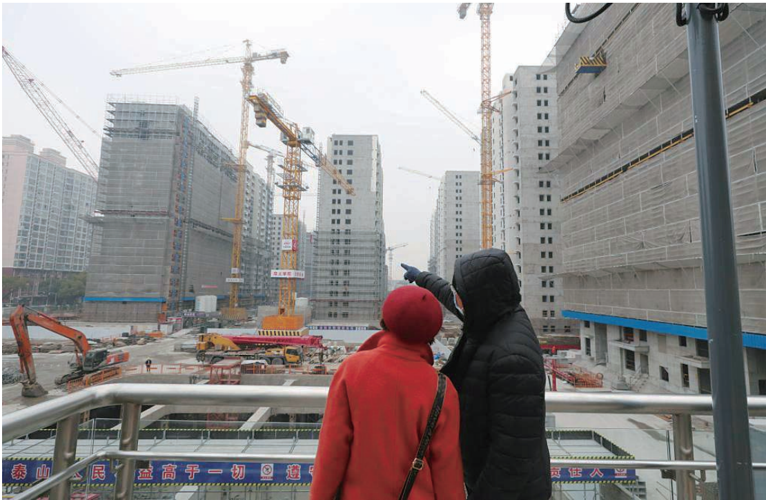
1月10日，两位市民在上海彭浦新村地铁站出站天桥上观看一建筑工地。
