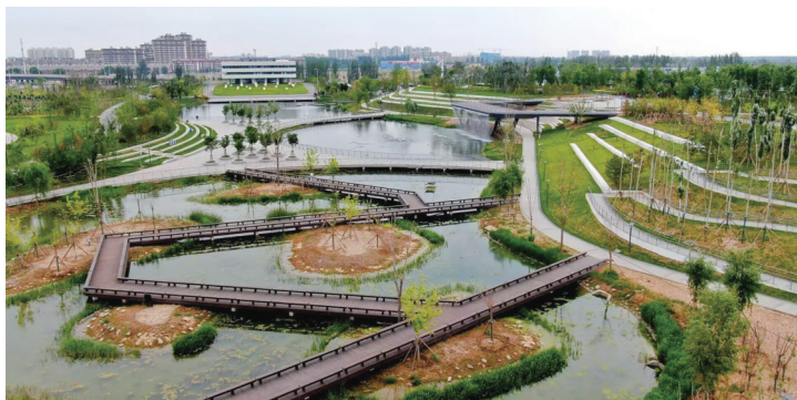
银川市第一再生水厂节水主题公园内水系丰富。资料图片(2023年6月摄)
