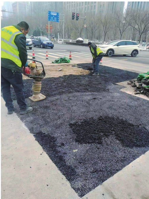
市政工作人员修补路面。记者李鲲鹏 摄
