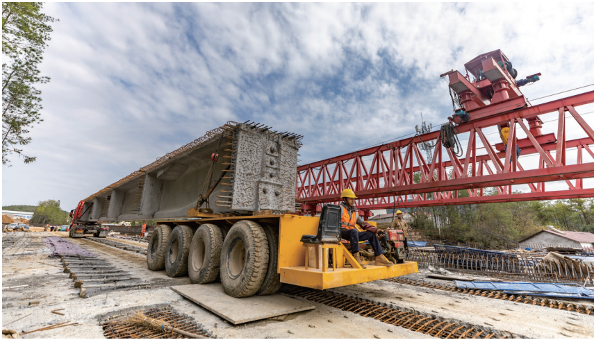
3月27日,重庆巫云开高速正在紧张施工。
