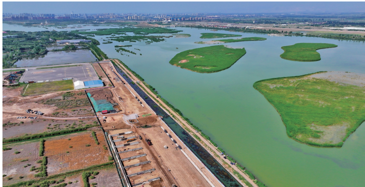
在银川市第六污水处理厂片区再生水生态利用工程现场,机器轰鸣,工人正在加紧施工。(资料图片) 记者 李靖 摄
