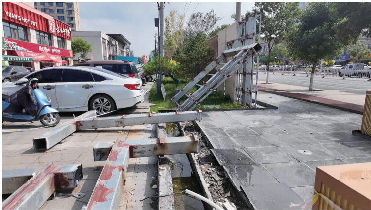
被拆除了一半的景观墙。
