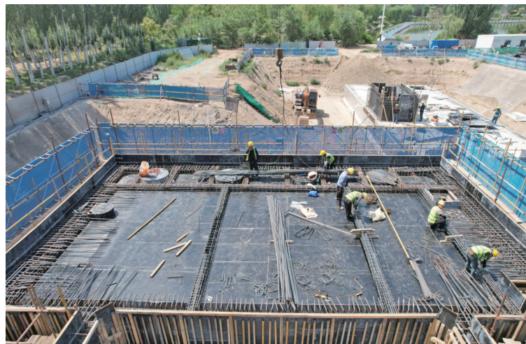
施工现场。记者 梁小雨 摄
