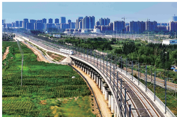
包银高铁惠银段全线拉通试验完成。记者 吴昊 马志伟 摄
