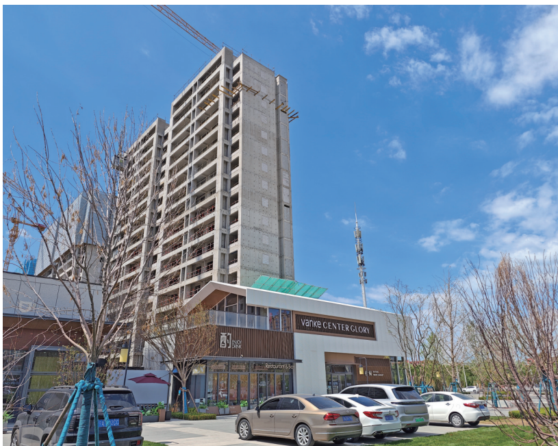
中房·万科锦曜项目建设现场。
