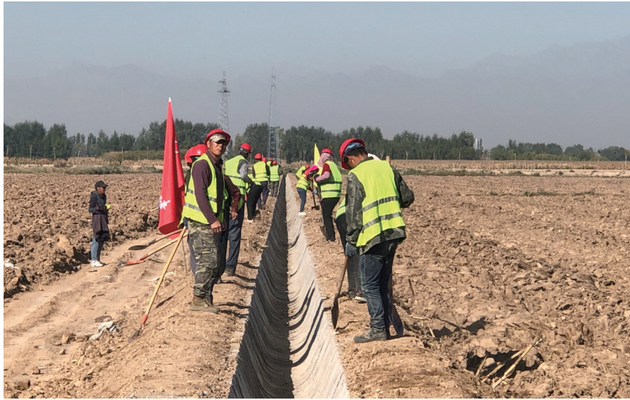
贺兰县农田水利建设现场。记者 田鑫 见习记者 陈星彤 摄
