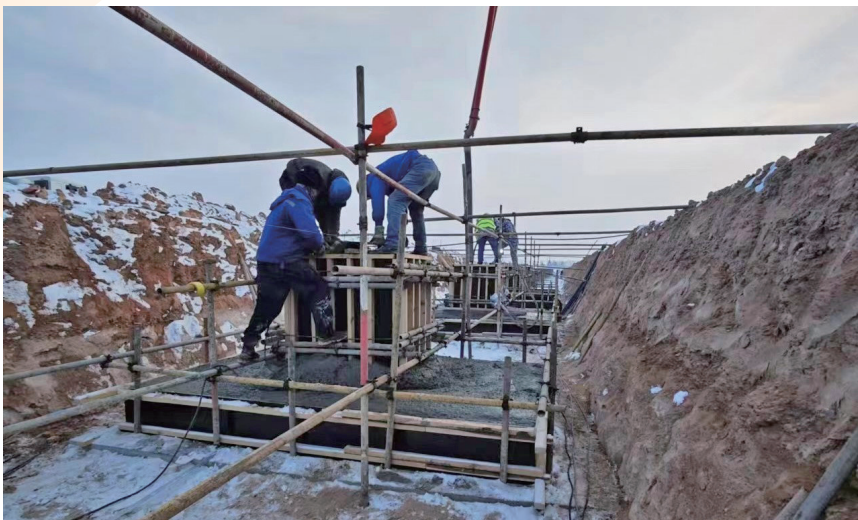
宁夏闽宁旺城乡乳制品有限公司乳制品加工项目建设现场。
