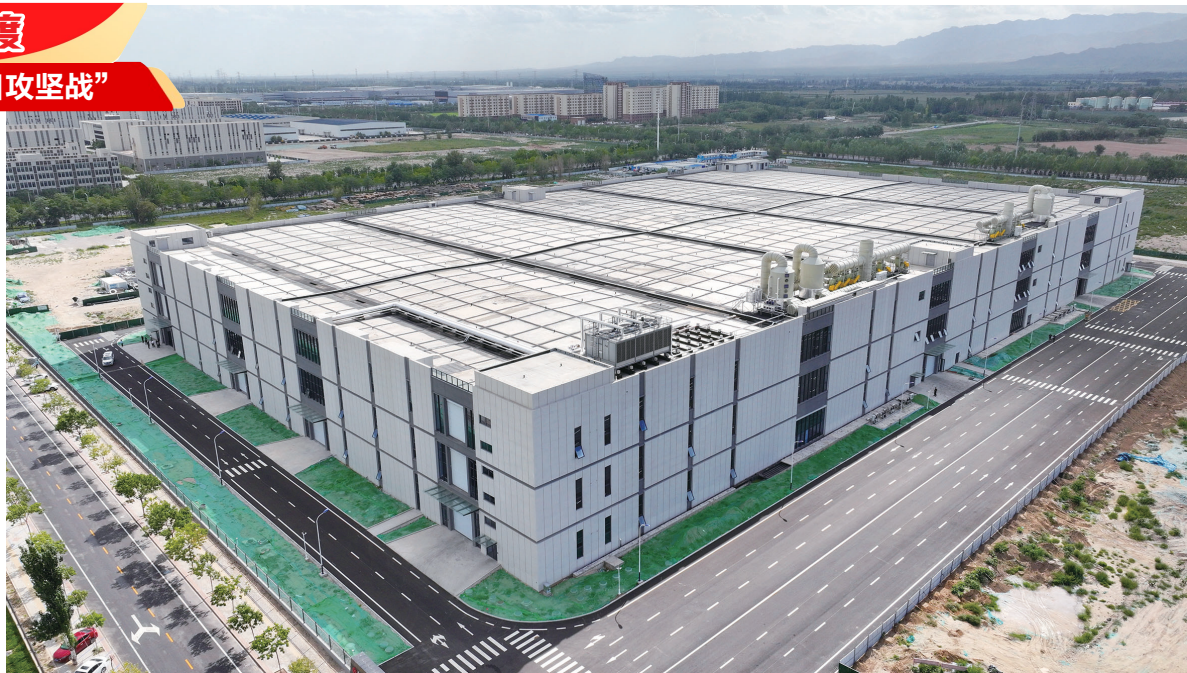
宁夏晶钰新材料科技有限公司年产10000万千米金刚线项目。 资料图片
