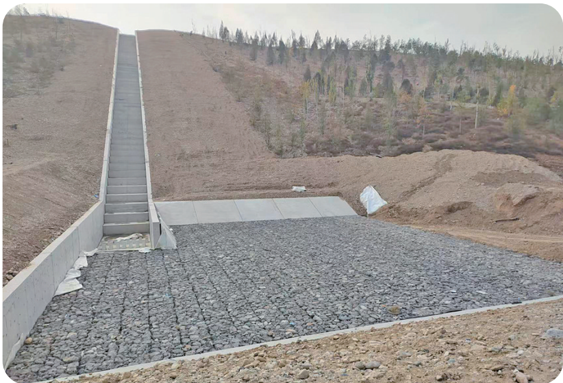
贺兰山东麓防洪治理工程一隅。 记者 李鲲鹏 摄
