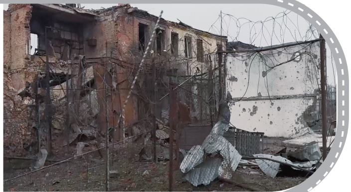
库尔斯克州一个定居点被损坏的建筑。新华社发
