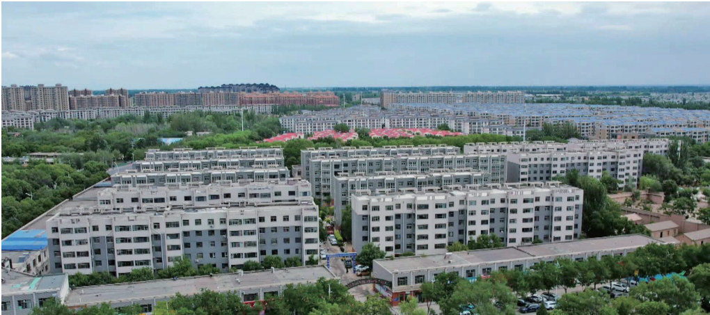
老旧小区改造让居民“住有宜居”。
