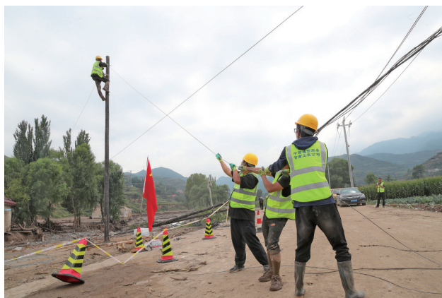
8月9日,在榆中县小康营乡南北关村,通信保障人员抢修一处通信设施。
