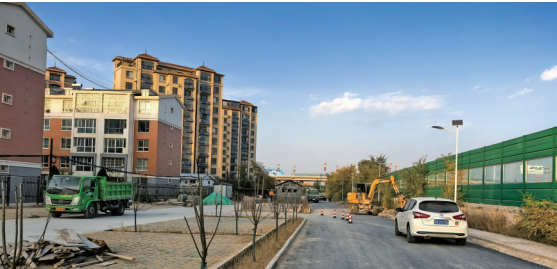
临河村道路更新。
